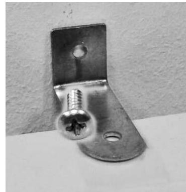
Kupevnění umístěte držák nahoře topení (viz obr.), kratší stranou směrem ke zdi. Označte místo otvoru na stěně a topení odstraňte. Vyrtejte na označeném místě dírku a opatřete ji hmoždinkou. Zavěste nyní topení opět na své místo a našroubujte držák na stěnu podle obrázku. Topení je nyní připevněno na své místo.
