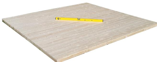
Fußbodenelemente von unten behandeln, zusammenlegen, umdrehen und mit einer Wasserwaage ausrichten.
