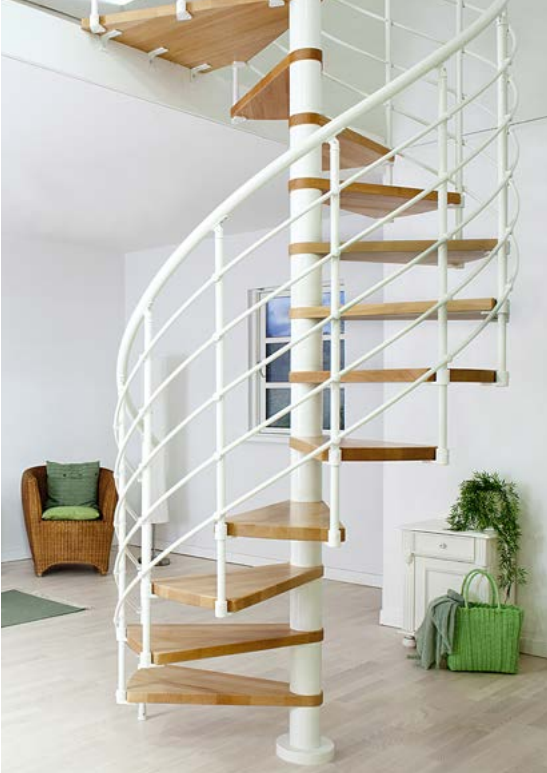
Nebentreppe mit Metallkonstruktion und Holzstufen
