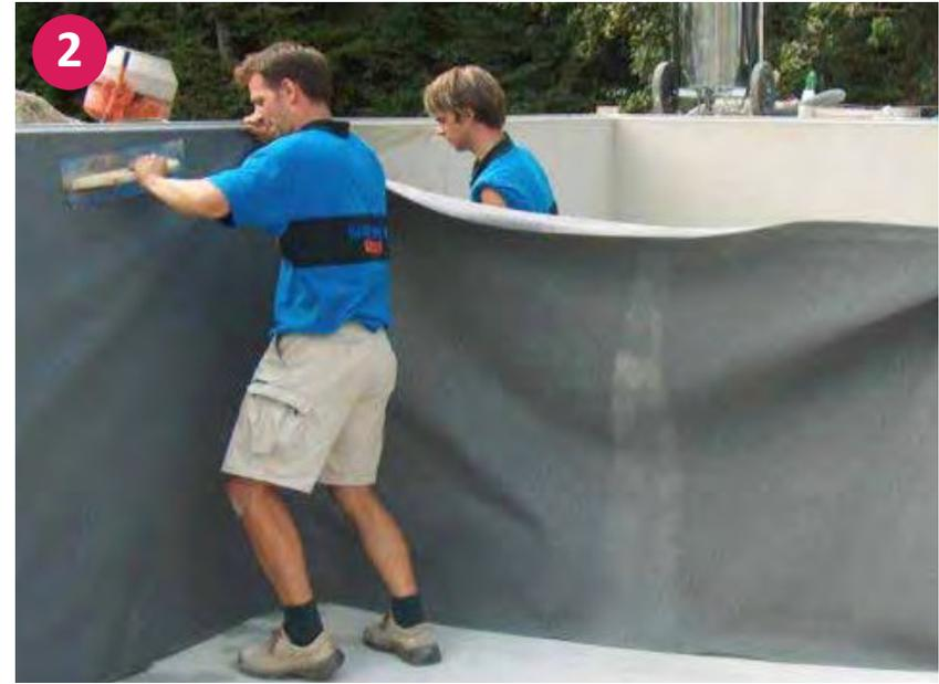
▲ Punktuelle Befestigung der Vliestrennlage mittels Styroporkleber
