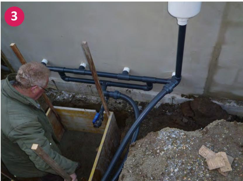
▲ Verrohrung von Düsen, Skimmer und Bodenablauf
