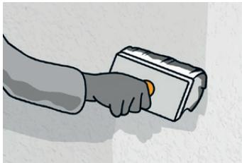
Die Fassadengrundierung unverdünnt, satt und gleichmäßig mit der HORNBACH Tiefgrundbürste auftragen.
