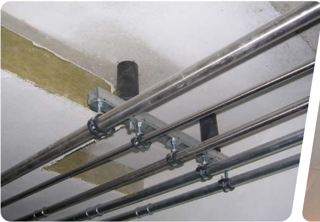
Decke: Topdec Universal, geklebt + gedübelt, gespachtelt
