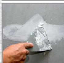
HORNBACK Dekorputze sind auf einen geraden, unbeschädigten Untergrund aufzubringen. Löcher oder Beschädigungen unbedingt vorher beispachteln.
