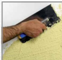
In einem weiteren Arbeitsgang ziehen Sie mit steil gestelltem Edelstahlglätter scharf auf Kornstärke ab. Dies ist ein entscheidender Teil der Arbeit, da erst die richtige Schichtstärke gleichmäßiges Strukturieren ermöglicht.
