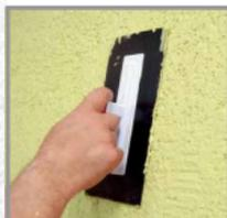
Nach dem Abziehen verwenden Sie den Kunststoffglätter zum Strukturieren. An ihm bleibt der Putz nicht haften. Der Glätter wird vollflächig aufgesetzt und je nach der gewünschten Struktur über die Fläche gerieben.
