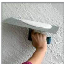
Tragen Sie den Putz auf – je nach Produkt mit Rolle oder Kelle. Die Auftragstärke hängt entscheidend von der gewünschten Struktur ab. Bevorzugen Sie z.B. rustikalere Strukturen ist eine hohe Schichtstärke erforderlich.
