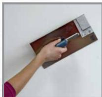
Der Putz wird oberflächlich geglättet um eine gleichmäßige Schichtstärke zu erreichen. Nicht mehr Material auftragen, als in ca. 15-20 Minuten strukturiert werden kann.
