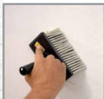
Rohes Mauerwerk verputzen: Das zu verputzende Mauerwerk darf keine losen Teile haben. Es muß fest, trocken und tragfähig sein. Eine Grundierung verbessert die Haftung des Putzes.
