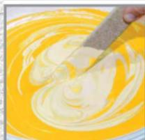
Bei farbigem Putz die HORNBACK Putz-Grundierfarbe zur Vorbehandlung im entsprechenden Ton abtönen. Bei stark saugenden Untergründen HORNBACK Acryl-Tiefengrund verwenden, um die Farbwirkung gleichmäßig zu gestalten.
