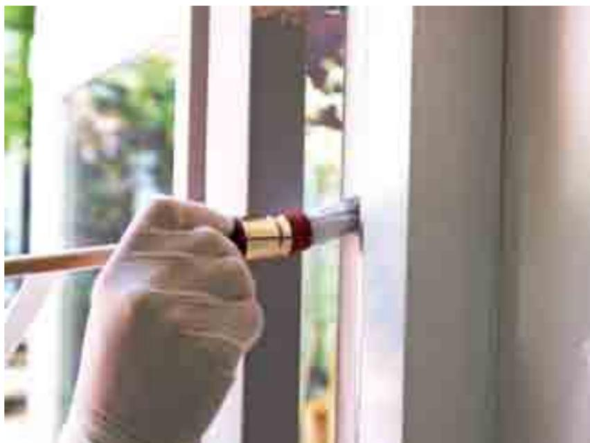
Bei maßhaltigen Bauteilen, wie z.B. Fenster und Türen, werden blockfeste Lasuren verwendet. Diese haben eine hohe Wasserdampfdurchlässigkeit, sehr hohe Elastizität und eine hohe Wetterbeständigkeit.
