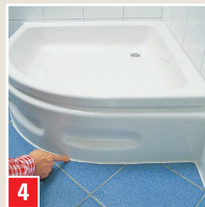
Dichtstoff innerhalb 10 Min. mit FUGENGLÄTTER (angefeuchtet mit SILICONGLÄTTMITTEL) abziehen.
