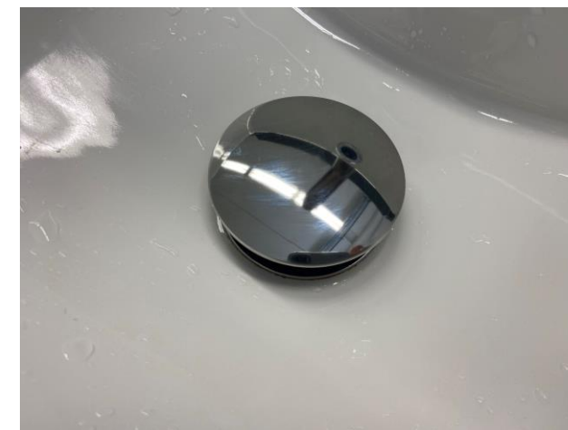
Verschluss wieder einsetzen
