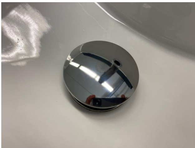
Verschluss öffnen nach oben heraus ziehen
