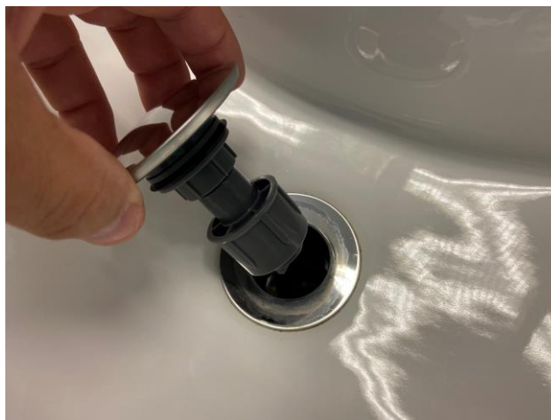
Verschluss öffnen nach oben heraus ziehen
