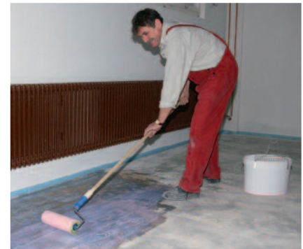
PCI Gisogrund Rapid wird mit einer feinporigen Schaumstoffwalze unverdünnt und gleichmäßig satt auf den mineralischen Untergrund aufgetragen. Nach der Verfilmung können sofort die nachfolgenden Arbeiten ausgeführt werden.
