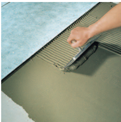
1. Auf den vorbereiteten Untergrund PCI Flexmörtel, PCI Flexmörtel-Schnell, PCI Nanolight oder PCI Nanoflott light aufkämmen.
