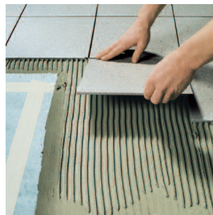
6. ... weitestgehend hohlraumfrei verlegt werden.
