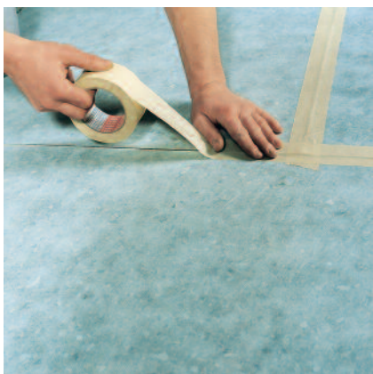
4. Zur Vermeidung von Schallbrücken Stöße mit Klebeband überkleben.
