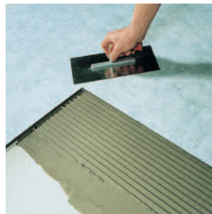
3. ... und mit einer Glättkelle andrücken.
