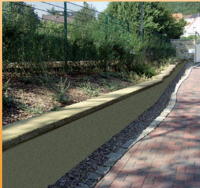
Beton-Schalungssteine, verarbeitet als Stützmauer, verputzt, mit Mauerabdeckung.
