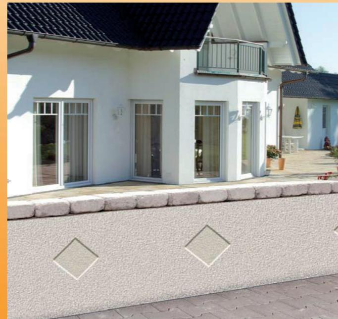
Beton-Schalungssteine als freistehende Mauer, verputzt, mit Mauerabdeckung.
