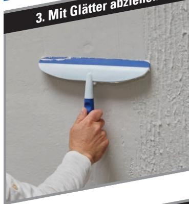
Ziehen Sie die Fläche mit dem MODULAN Spezialglätter ohne Trocknungszeit ab, bis eine gleichmäßige Oberfläche entstanden ist. Üben Sie dabei konstant leichten Druck aus.
