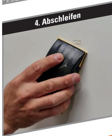
Bei Bedarf können Sie die Wand nach der vorgegebenen Trocknungszeit zusätzlich abschleifen, um so eine noch feinere Oberfläche zu erzielen.
