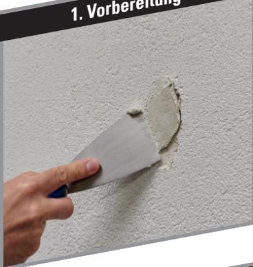
Untergrund reinigen und Löcher, die tiefer als 1,5 mm sind, z. B. mit MODULAN 350 Reparaturspachtel auffüllen.
