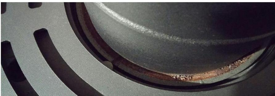
*Lackschaden durch Kondensationsvorgänge im Schornstein*
